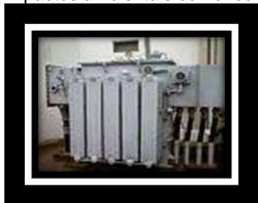
Transformador elétrico contendo ascarel
