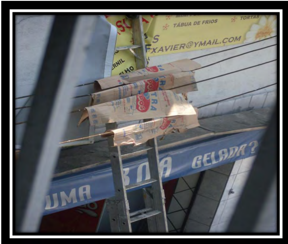
Trabalho com alto risco, pois o isolamento dos fios foi feito com papelão.
