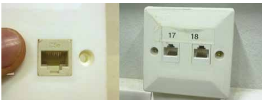
Figura 48 - Conexão correta e conexão incorreta
