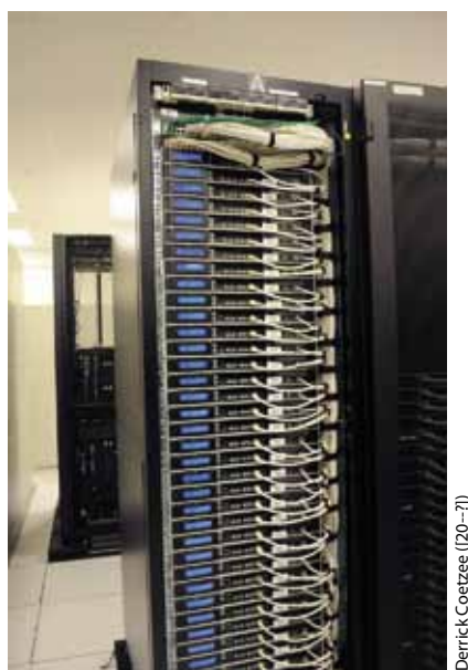
Figura 63 - Organização dos cabos no rack
