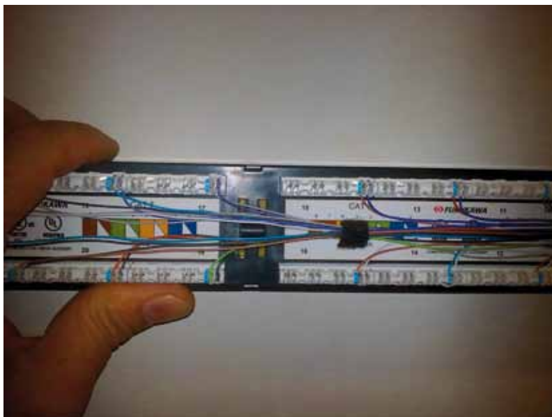
Figura 100 - Conexão condutores do cabo - 25 pares no par 01 do patch panel
