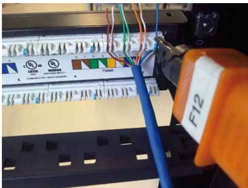
Figura 60 - Inserção com push down
