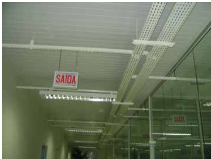
Figura 30 - Malha de distribuição de teto
