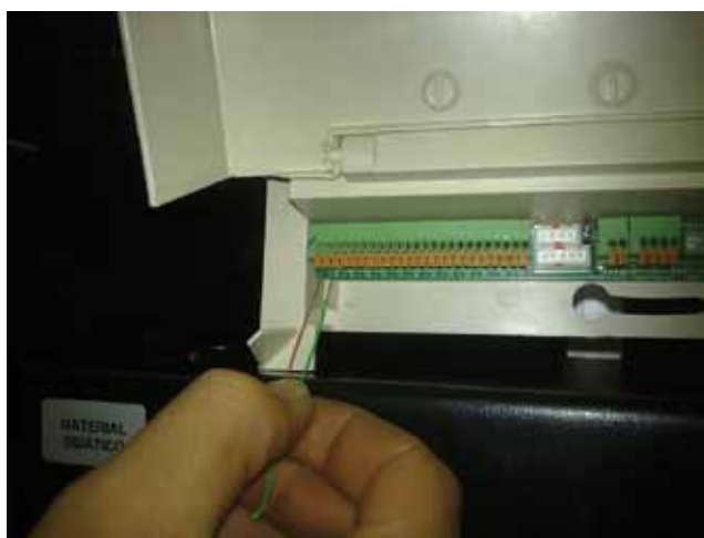
Figura 98 - Conexão de um par do cabo - 25 pares no primeiro ramal da central telefônica
