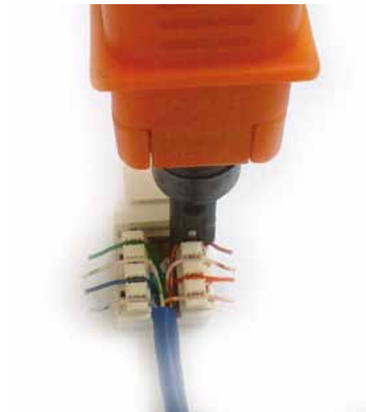
Figura 46 - Inserção dos condutores
