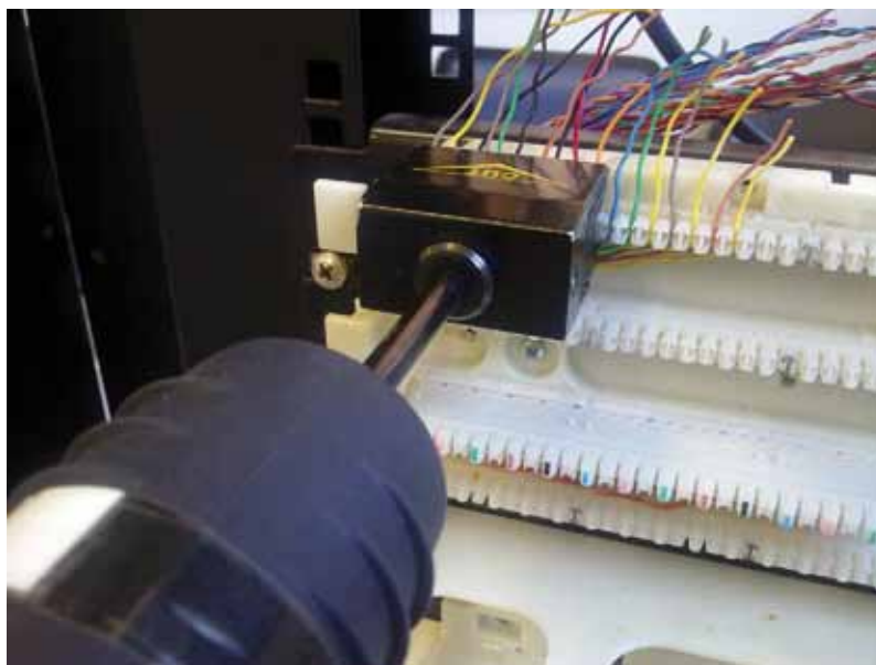
Figura 56 - Inserção dos Condutores no Bloco
