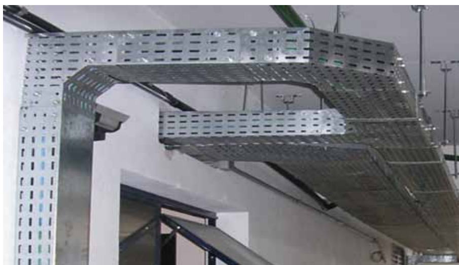
Figura 26 - Eletrocalhas
