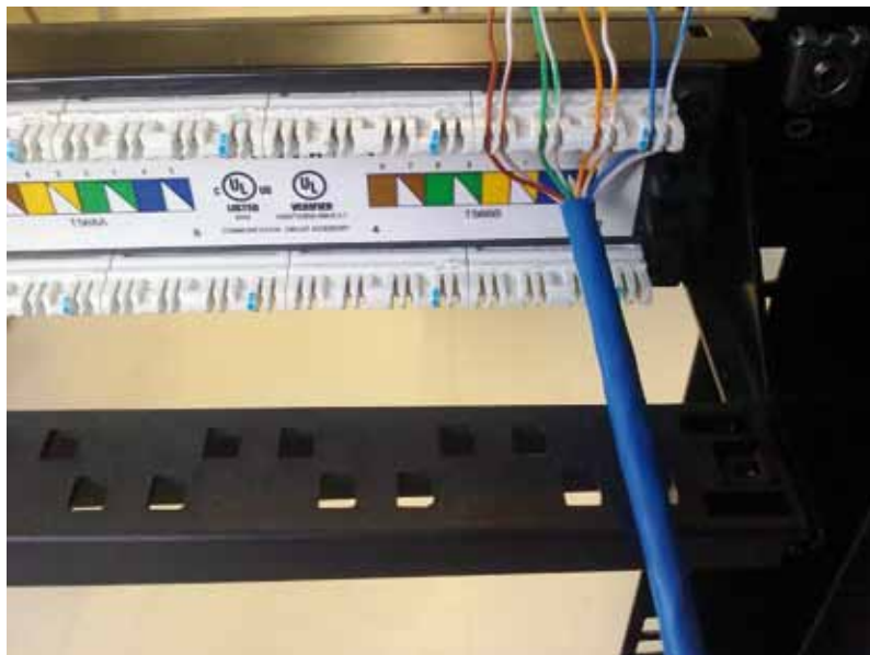
Figura 59 - Condutores no Patch Panel
