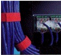
Figura 18 - Cabos unidos com velcro ( correto )
