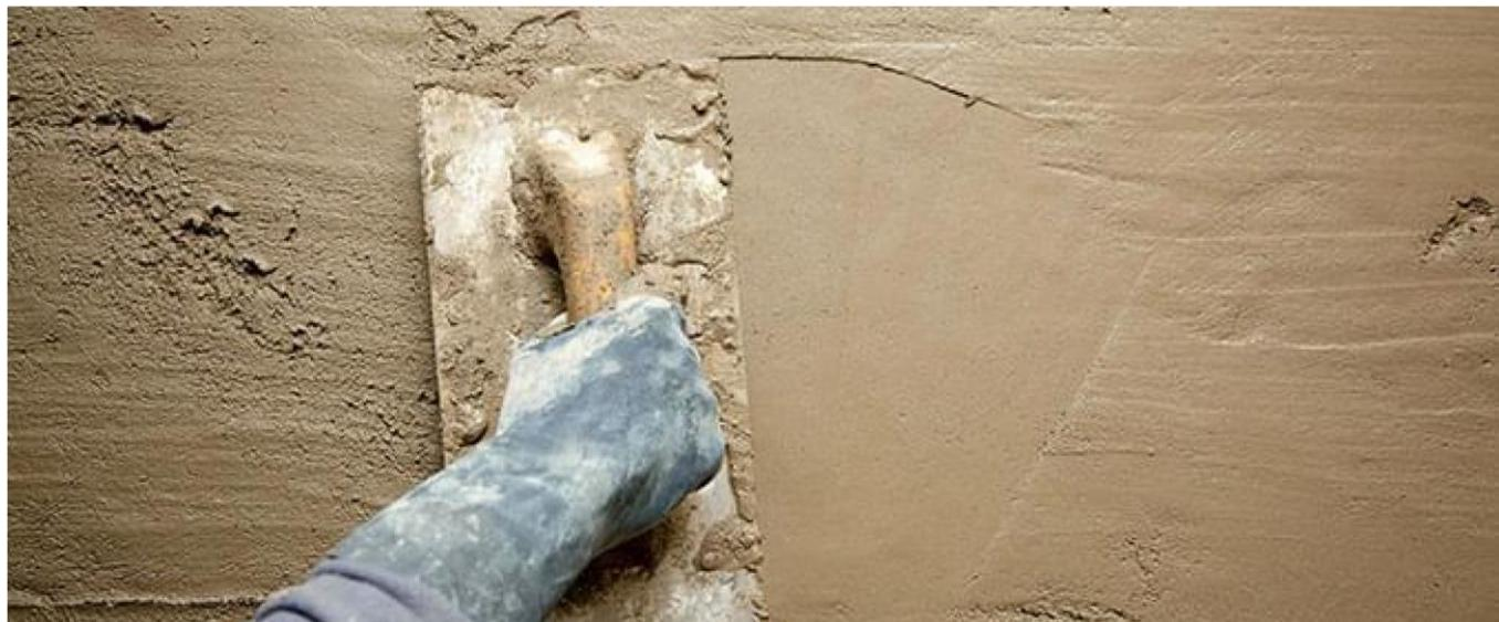
As argamassas são compostas por uma mistura homogênea de agregados miúdos, aglomerantes inorgânicos e água, usadas para o assentamento de tijolos e o acabamento de superfícies. Podem ou não conter aditivos ou adições, com propriedades de aderência e endurecimento – dosadas na obra ou através de processos industriais.
