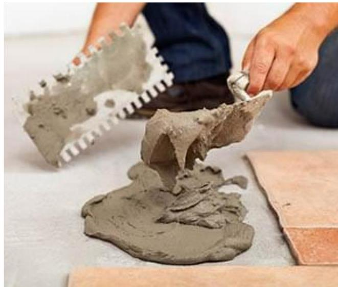
**Argamassas colantes** – As argamassas colantes têm a função de colar o revestimento. “Para essa tipologia, existem três perguntas fundamentais: o tipo de argamassa que será utilizado, qual o tamanho da peça do revestimento e onde será aplicada - área interna ou externa, por exemplo”, indica Matsumoto. Na argamassa colante o produto também é entregue pronto, já contando com cimento, areia e aditivos. “É necessário somente adicionar água, misturar e está pronta para aplicação”, completa.
