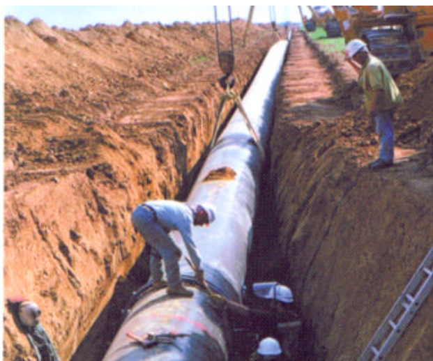
Técnicos preparando a radiografia de uma junta soldada circular de uma tubulação numa vala, antes desta ser liberada.
