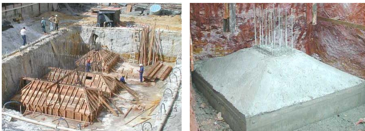
Figura 1.1: Fotos de execução de sapatas. Fonte: Fundacta
