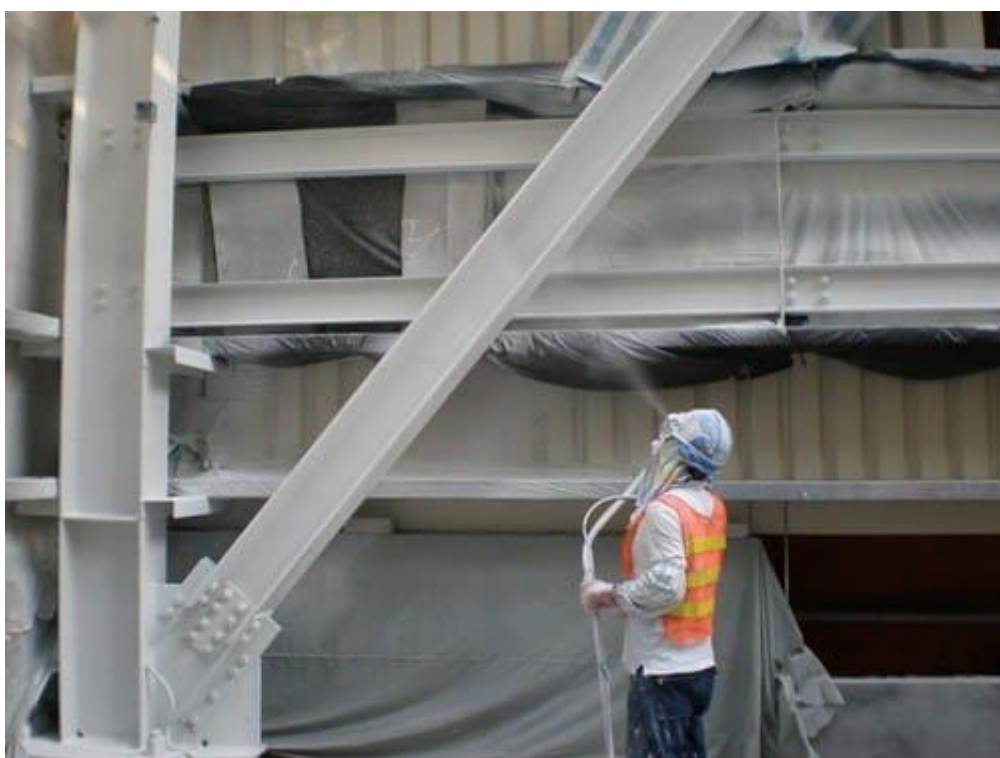
Como fazer pintura industrial: estrutura metálica (foto: o pintor consultoria)
