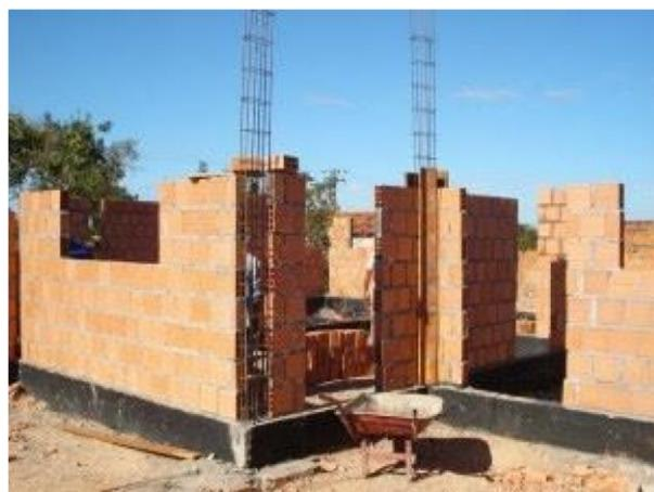
*Nesta construção a betonagem dos pilares é feita já com as paredes levantadas.*
