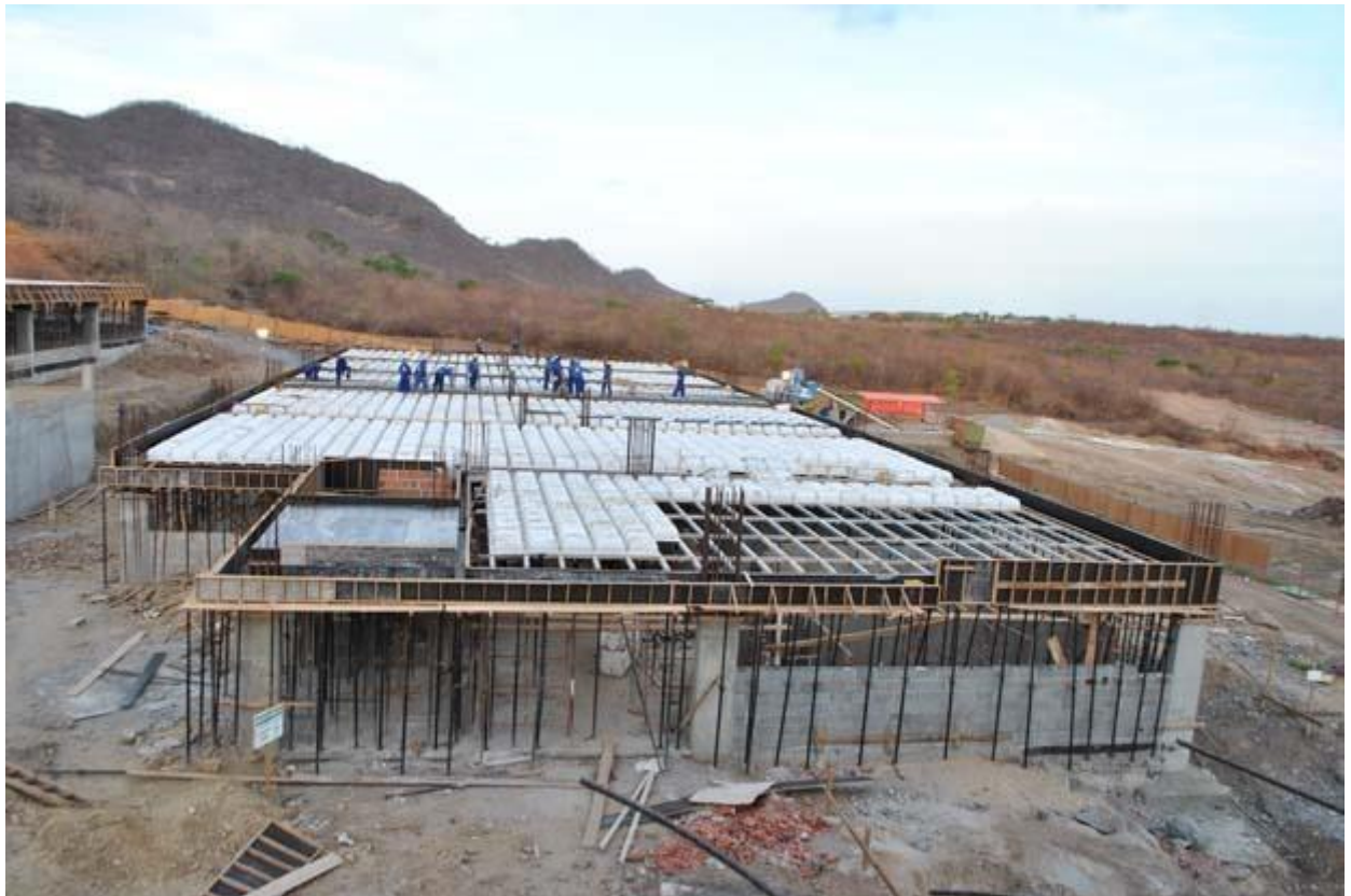
Preparação de uma laje para ser concretada.
