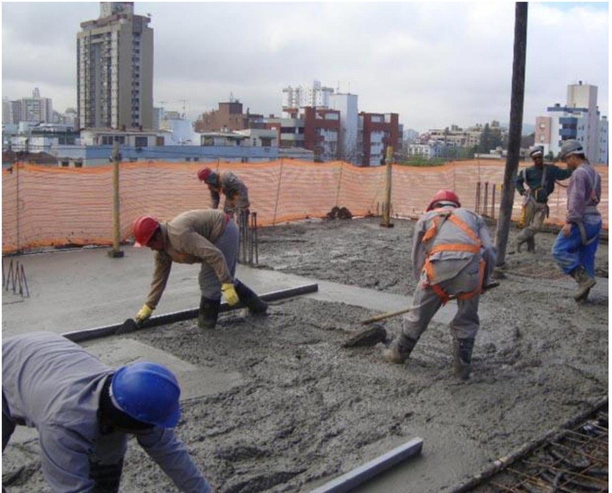
Sarrafeamento durante concretagem.
