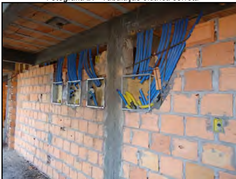
Fotografia 21 - Tubulação elétrica correta
