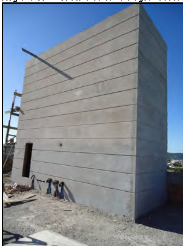
Fotografia 33 – Estrutura da caixa d'água rebocada
