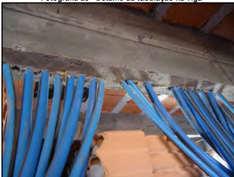
Fotografia 23 - Detalhe da tubulação na viga
