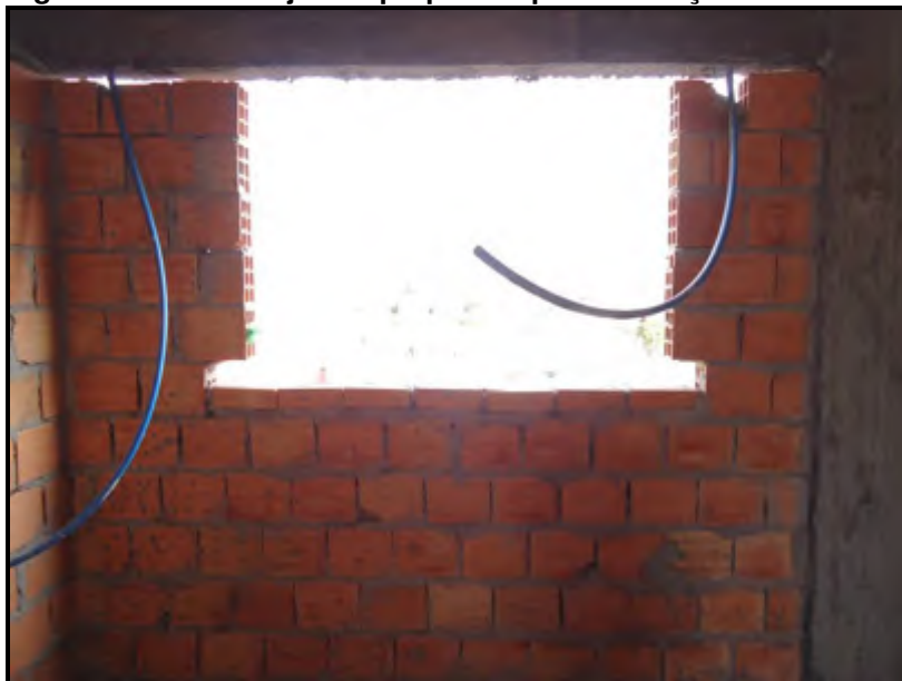
Fotografia 37 - Vão de janela preparada para execução de contra verga
