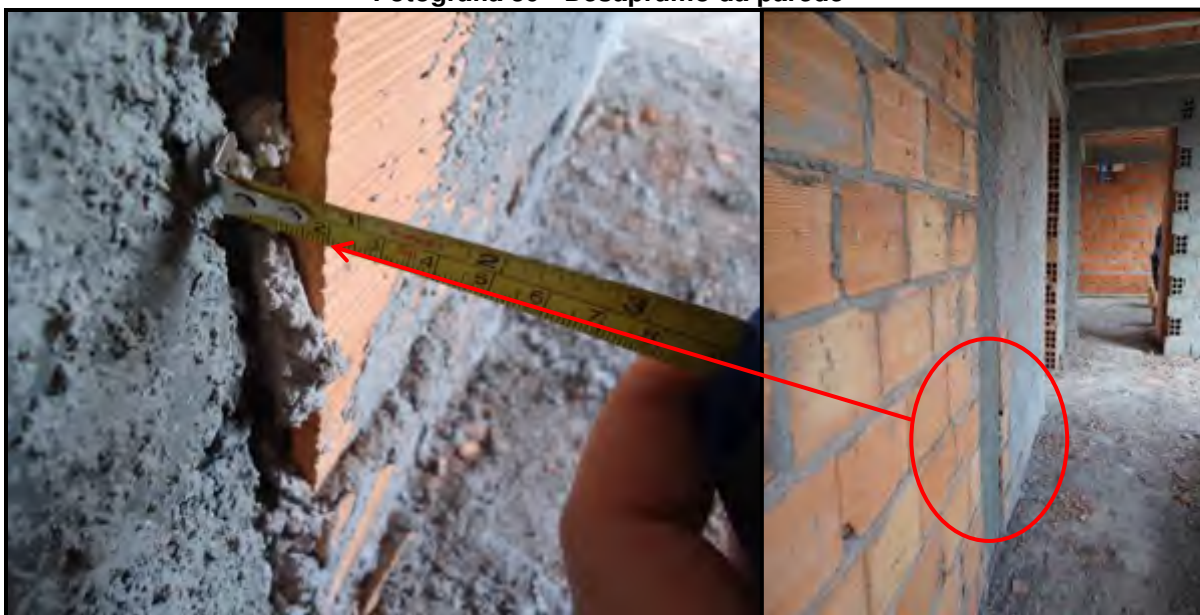
Fotografia 30 - Desaprumo da parede
