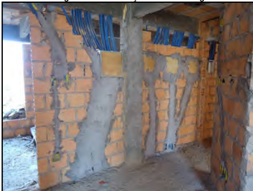
Fotografia 22 - Tubulação elétrica corrigida
