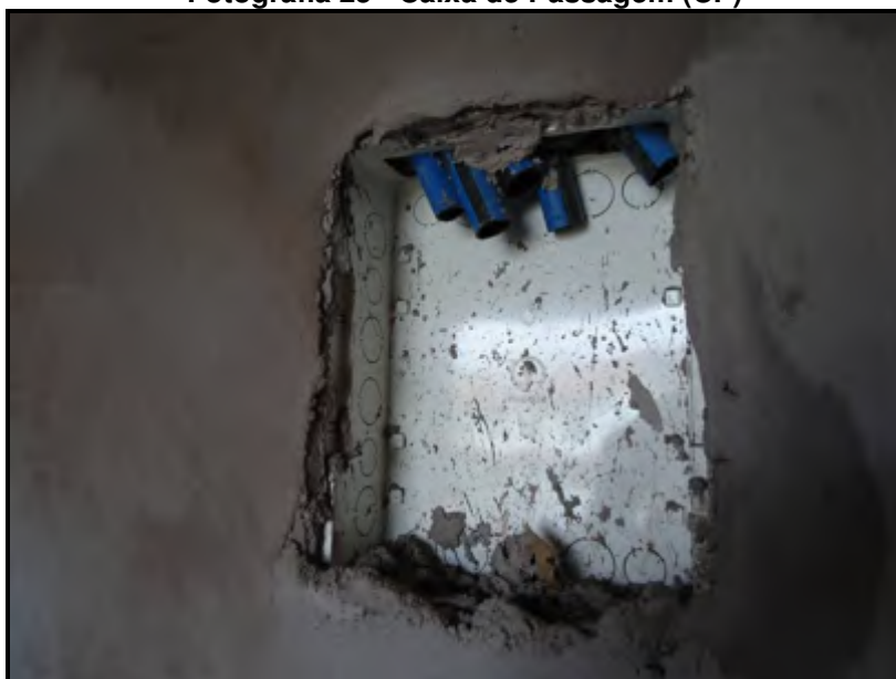
Fotografia 25 - Caixa de Passagem (CP)
