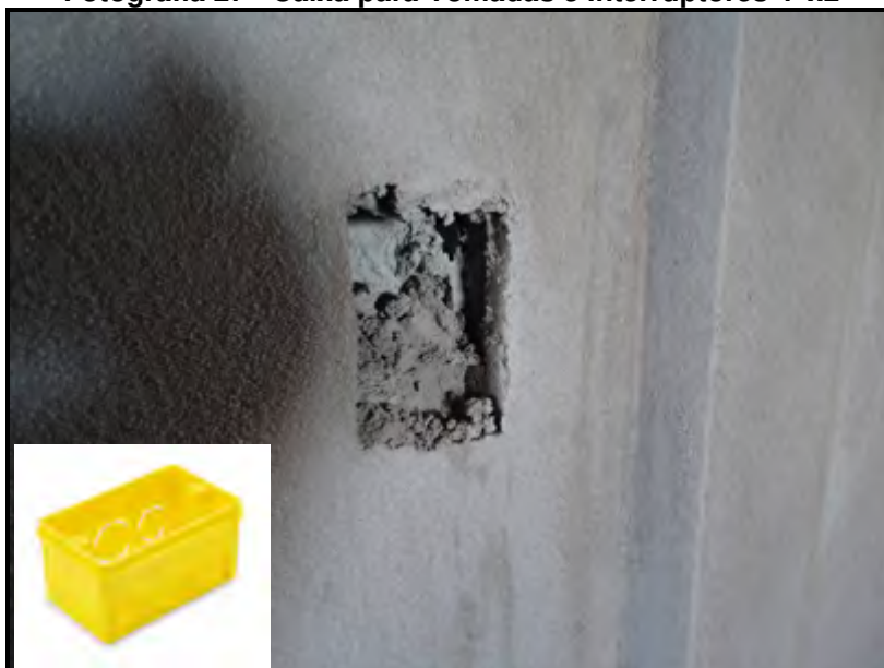
Fotografia 27 - Caixa para Tomadas e Interruptores 4"x2"
