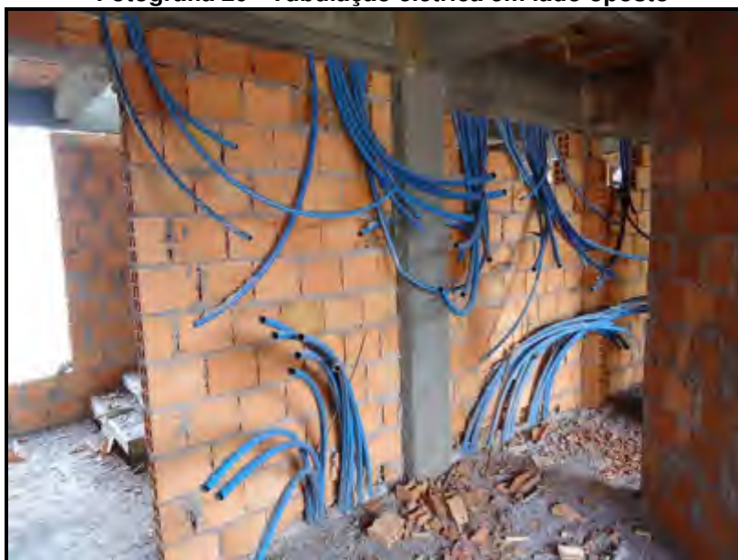
Fotografia 20 - Tubulação elétrica em lado oposto
