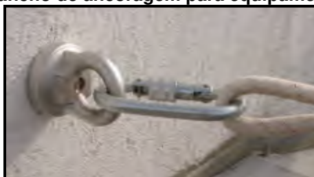
Fotografia 7 - Gancho de ancoragem para equipamento e segurança
