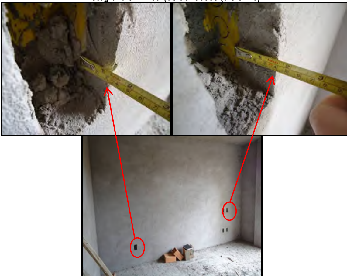
Fotografia 31 - Medição do reboco (disforme)
