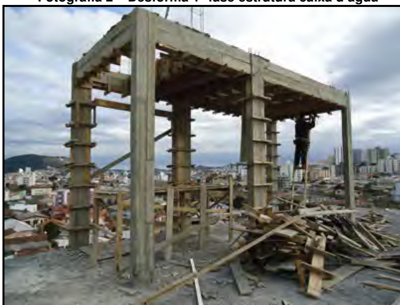
Fotografia 2 – Desforma 1ª fase estrutura caixa d'água
