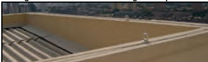
Fotografia 8 - Sistema de ancoragem em platibanda
