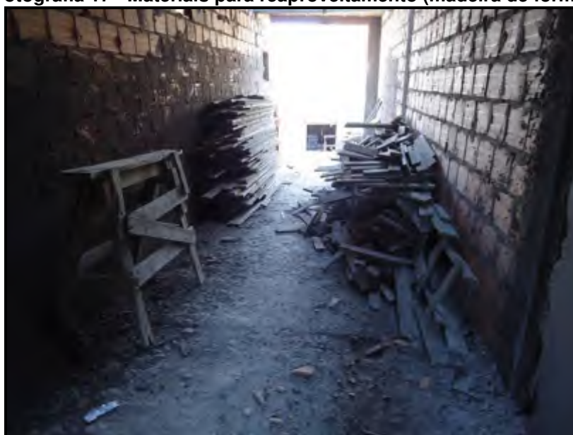
Fotografia 17 - Materiais para reaproveitamento (madeira de fôrmas)
