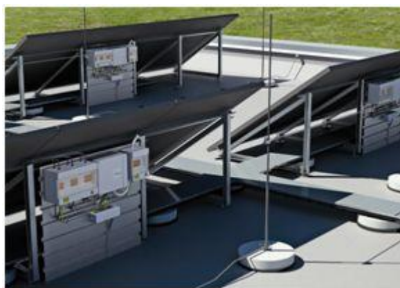
Figura 3 – Estruturas e bandejamento de um SFV.
