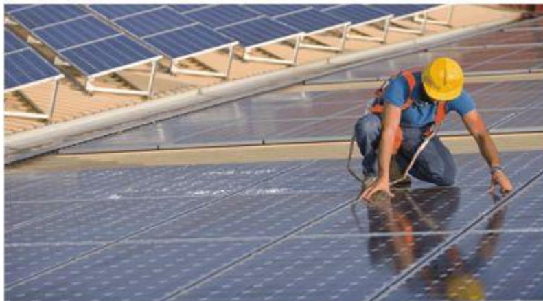
Figura 1- Painéis ou módulos de captação.
