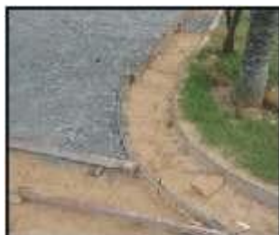
Nivelamento e compactação do subleito, colocação de brita, instalação de fôrmas e telas de aço.
