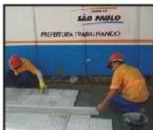
Conferência de nível, aplicação de argamassa de rejuntamento, limpeza e abertura ao tráfego.
