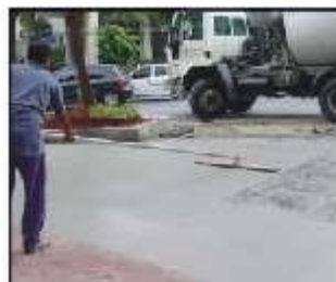
Desempeno do concreto (para acabamento convencional: desempenar, executar juntas e curar).
