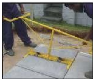
Colocação das peças de concreto com saca-placas.
