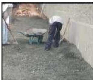
Instalação das contenções laterais, nivelamentos e compactação da base.
