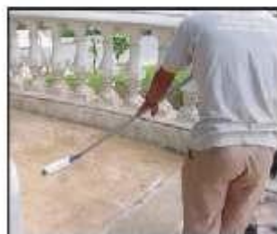
Execução de juntas de controle, lavagem, aplicação de resinas e liberação ao tráfego.
