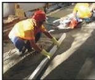
Sarrafeamento da argamassa (etapa não necessária para argamassa colante).
