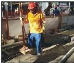
Aplicação e adensamento da argamassa de assentamento tradicional (ou argamassa colante).
