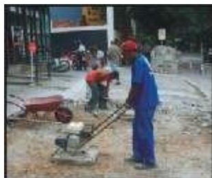
Nivelamento e compactação do subleito (terreno).
