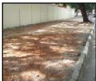
Nivelamento e compactação do subleito (terreno).
