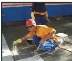
Aplicação de cimento pulverizado e água (etapa não necessária para argamassa colante).
