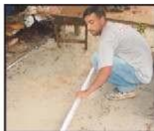
Espalhamento e nivelamento da areia de assentamento (ou pó de brita).
