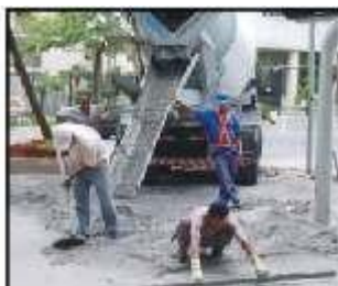
Lançamento, espalhamento e nivelamento (sarrafeamento) do concreto.
