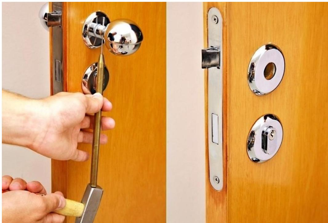
Com o auxílio da chave philips desparafuse a chapa da fechadura. **Solte os parafusos, tire o miolo da fechadura e a máquina.**
