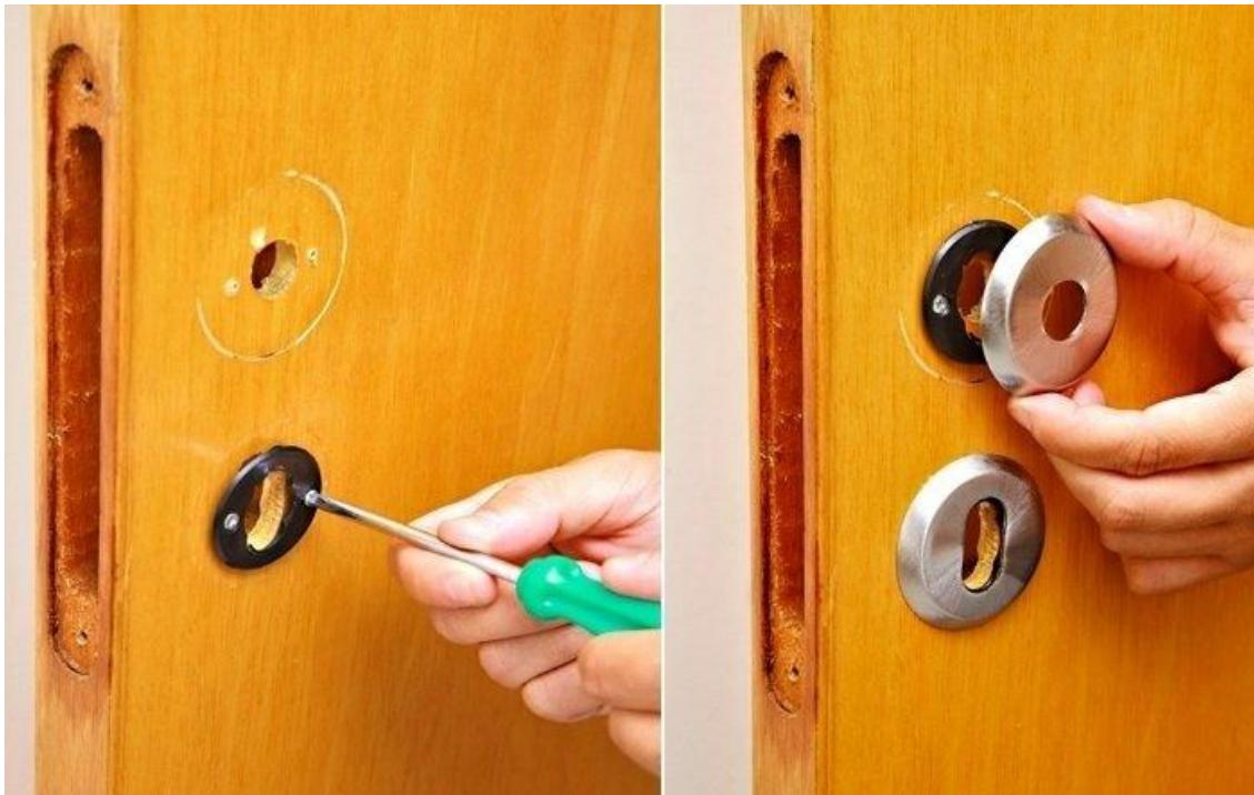
**Encaixe a máquina na porta e encaixe o miolo**, parafusando o miolo e a chapa na lateral da porta.
