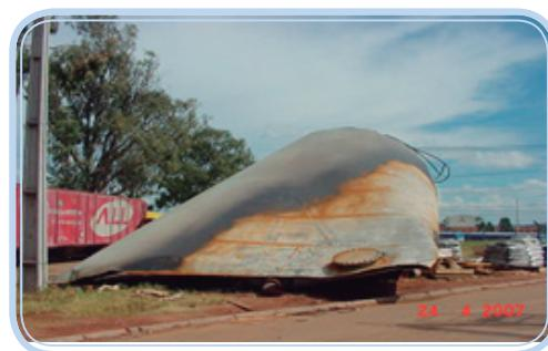
**Figura 20.1: Explosão em tanque de etanol**
