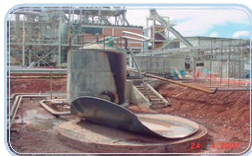
**Figura 20.2: Bacia de contenção e fundo de tanque que explodiu.**
