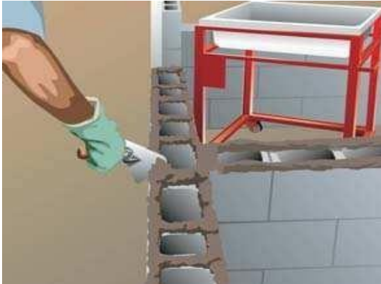
Figura 16 – Assentamento de bloco, ABCP, 2003.
